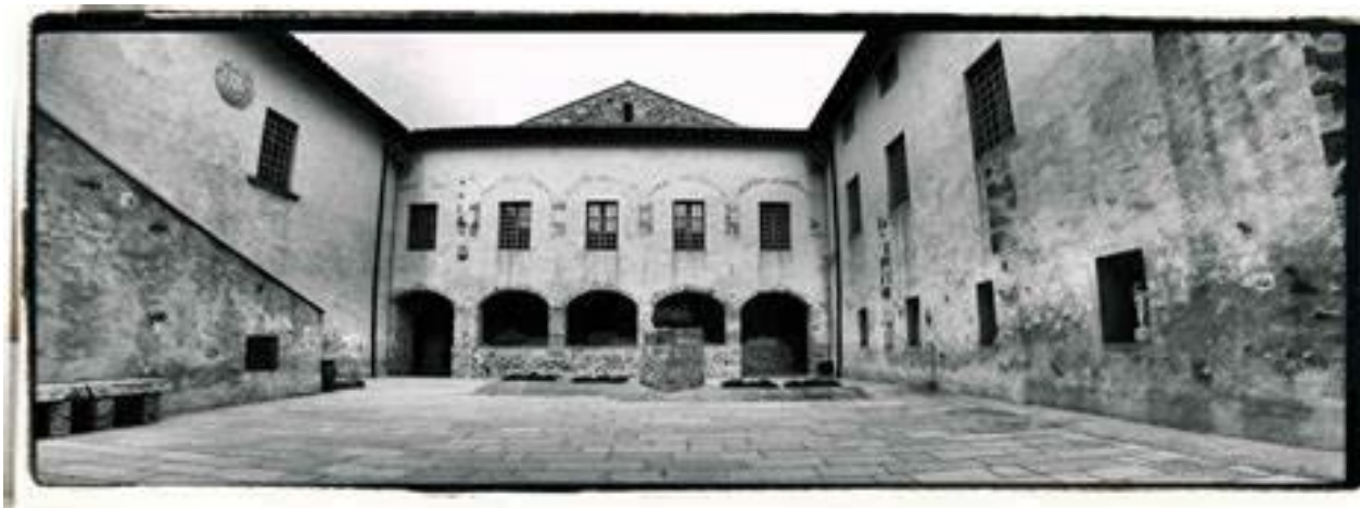
Chioostro prima del restauro
