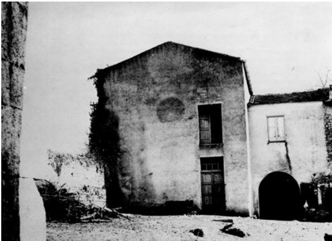
La facciata della chiesa trasformata in stalla prima del 1978
