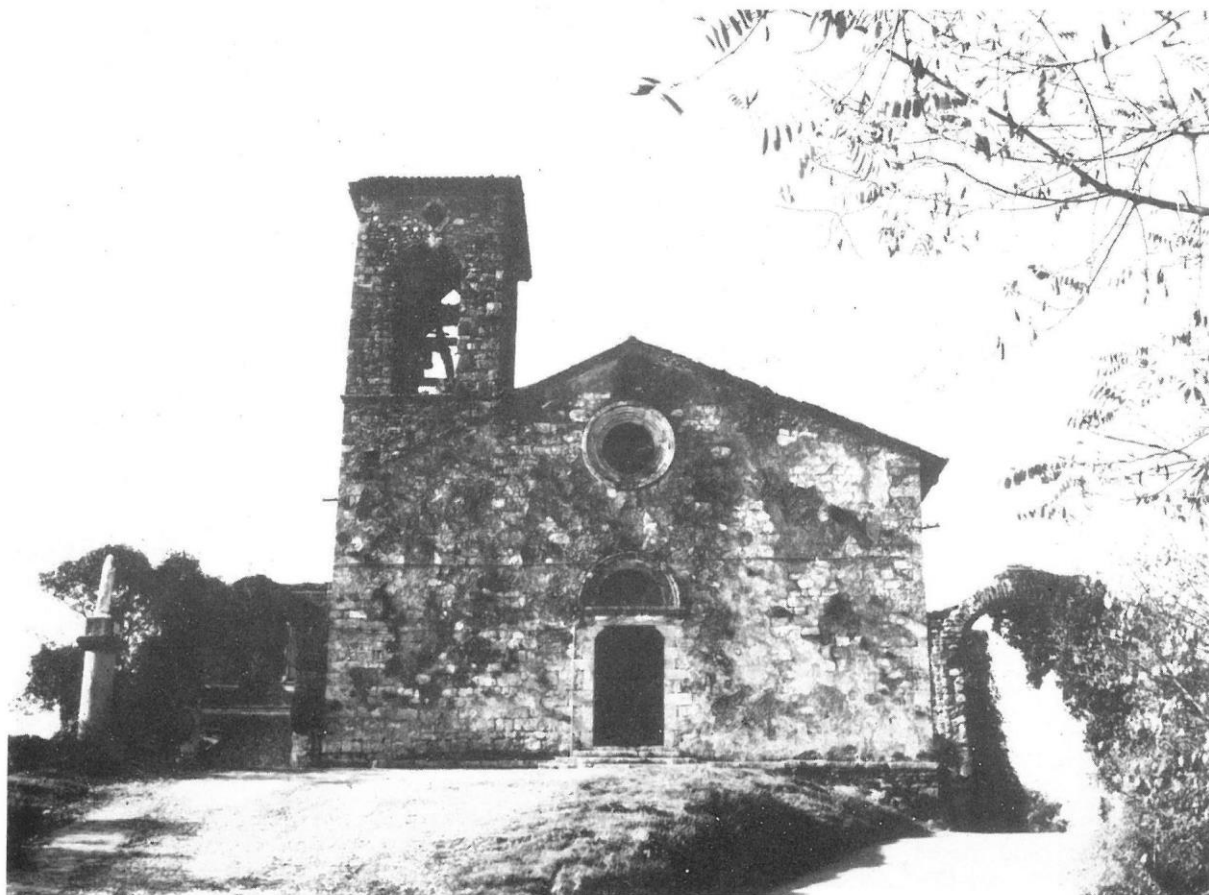
Fig. 2: facciata della chiesa con archetto su strada comunale
