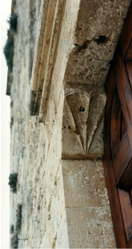
← Mensola con decorazione geometrica: porta di ingresso alla chiesa di S. Antonio abate di Ferentino – lato sud
