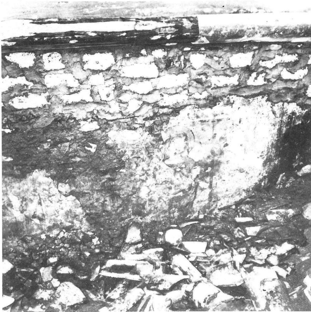
Figg. 8-9: affreschi rinvenuti su alcune pareti del sottotetto della chiesa
