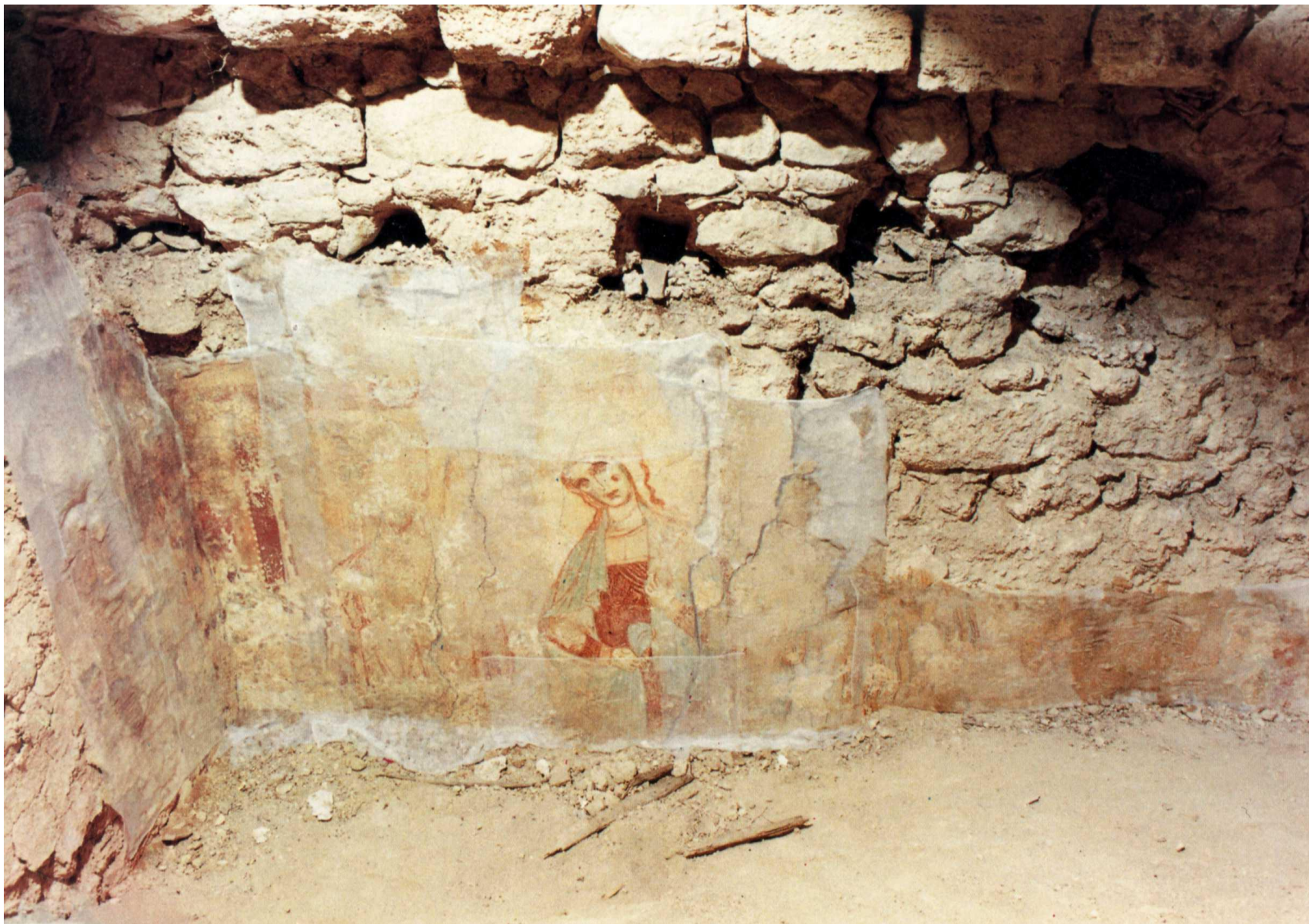
Ferentino, Affreschi del sottotetto della navata centrale della Chiesa di S. Antonio abate, secc. XIII ex. e XIV in. , durante i restauri del 1994
