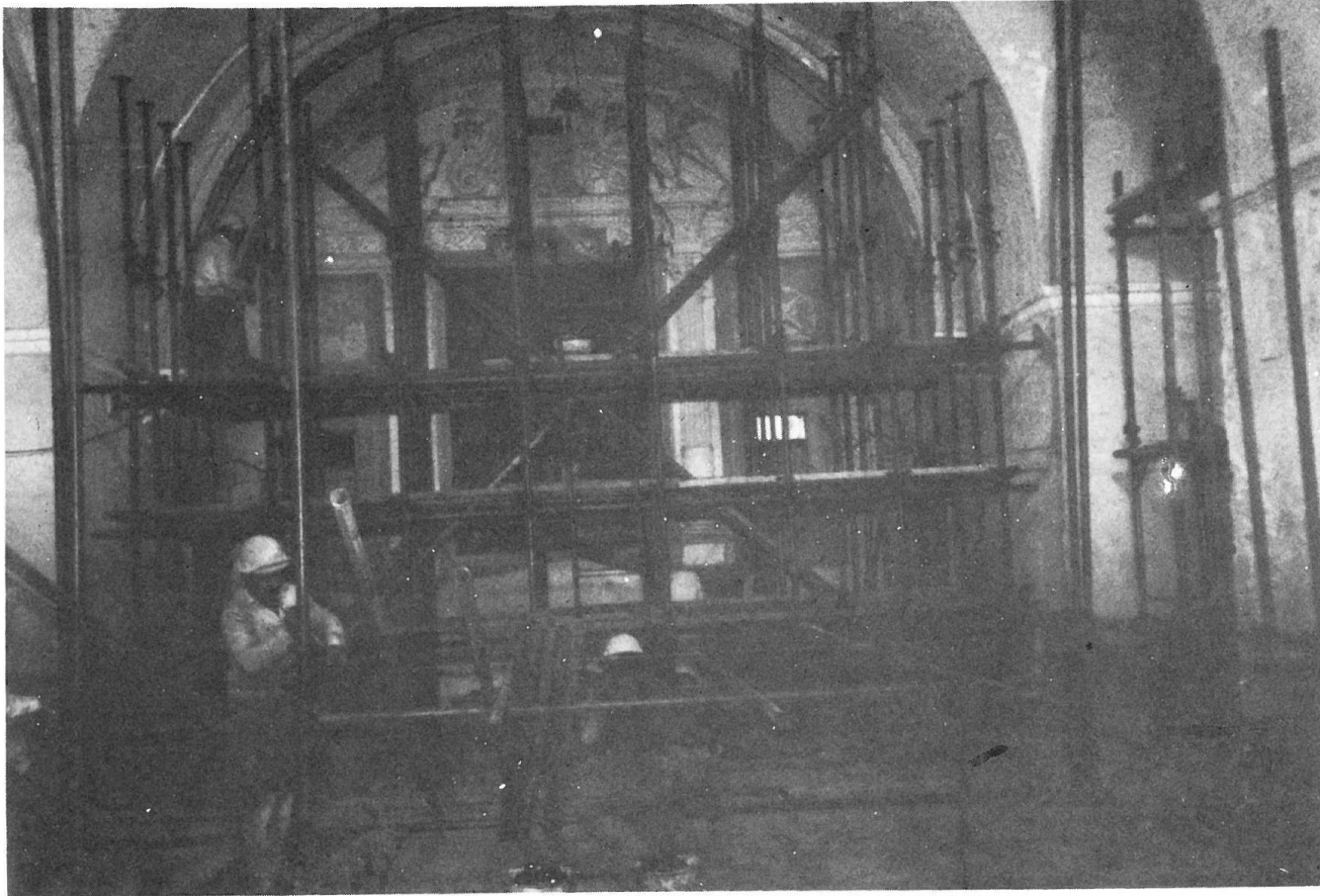
Fig. 12: lavori attuali: ponteggio interno di puntellamento delle volte e delle pareti
