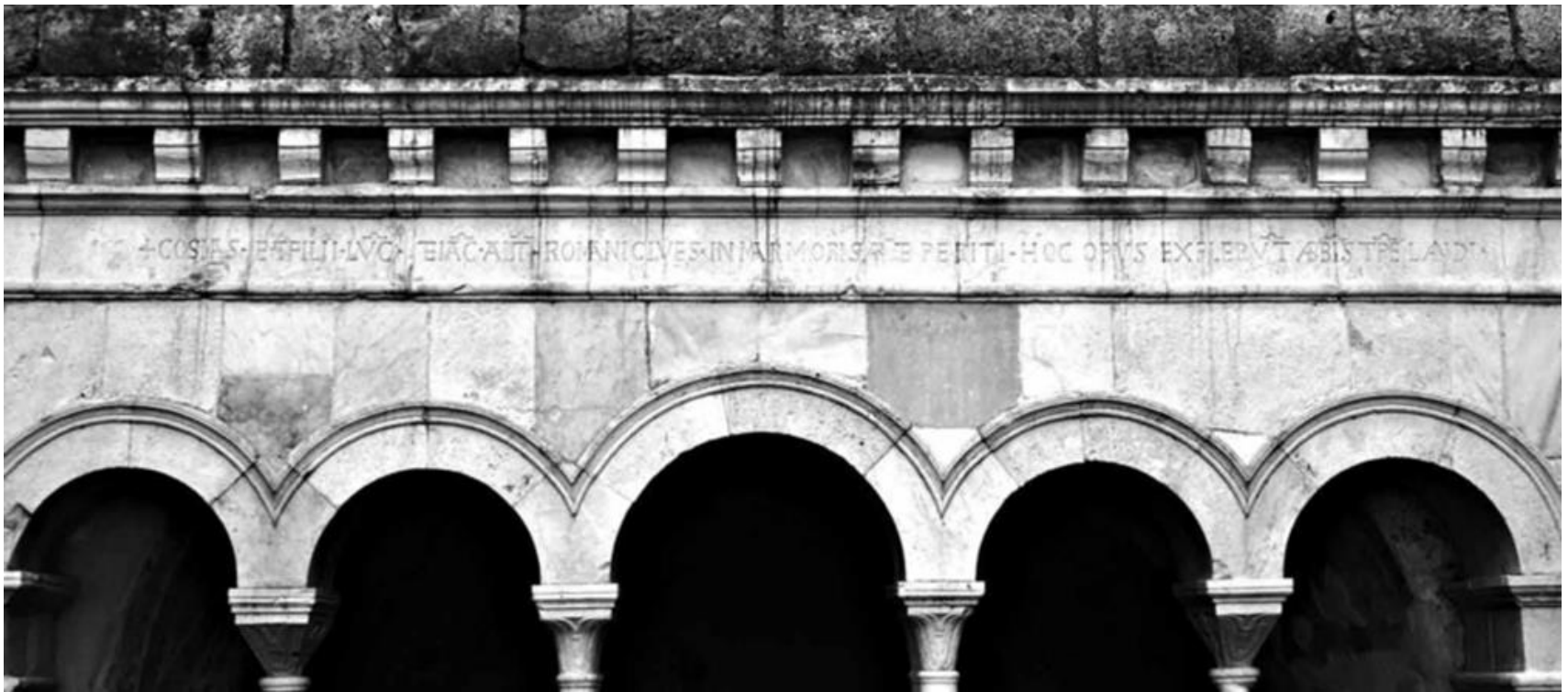
Subiaco, Abbazia di Santa Scolastica, chiostro “cosmatesco”, lato ovest foto di Manuela Gianandrea
