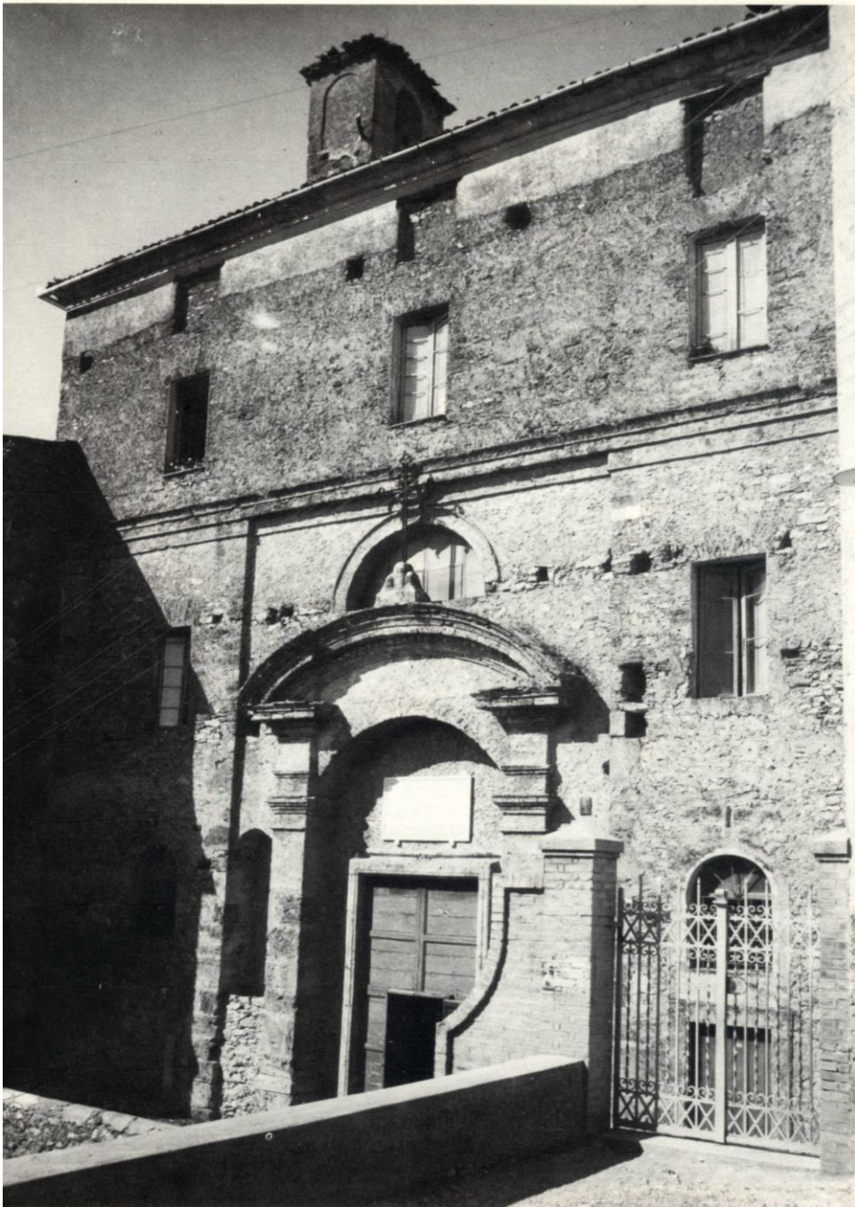
Ferentino, facciata della chiesa Madonna del Buon Consiglio prima del restauro (foto Emilio Collalti)
