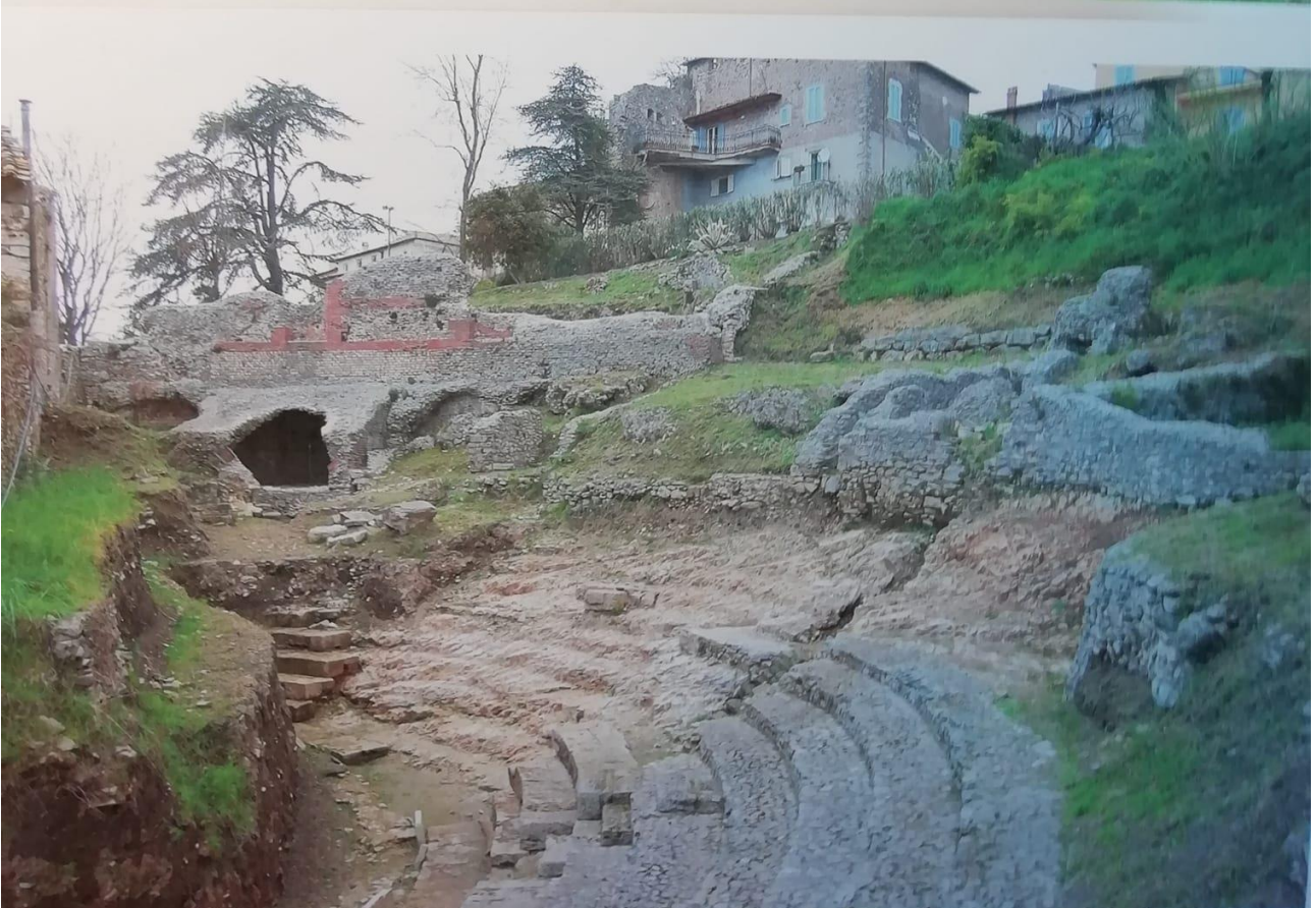
Ferentino, teatro romano (prima dei restauri) foto di Francesco Porretti
