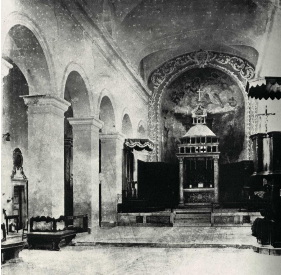
Ferentino, Cattedrale, interno secentesco prima dei restauri (anni 1896-1905 - da Zannella, 1980)
