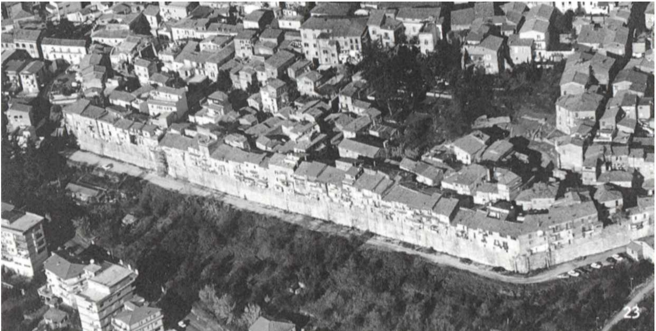
Ferentino – antiche mura romane, settore meridionale foto aerea
