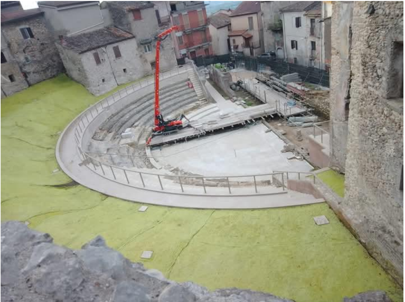
Ferentino, 12 maggio 2025, teatro romano lavori di restauro contemporaneo
