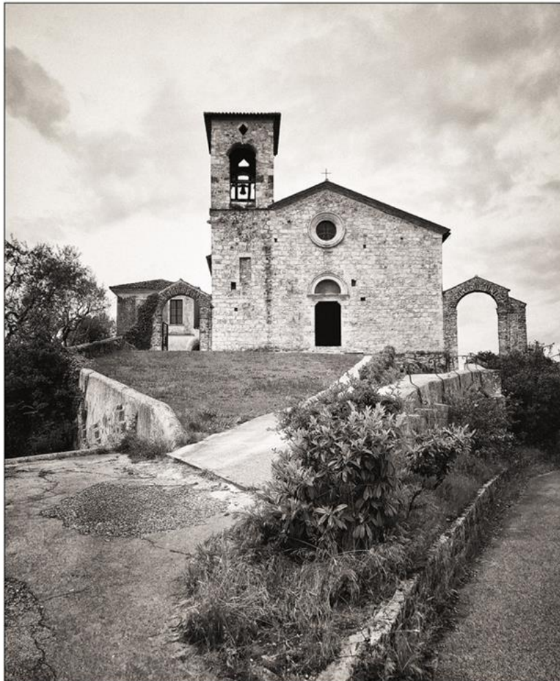
Chiesa di S. Antonio Abate - XIII sec. (facciata)
